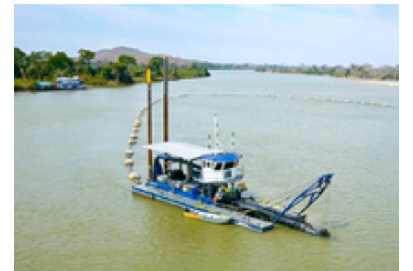
As obras de dragagem no Tramo Norte do Rio Paraguai, entre Cáceres (MT) e Corumbá (MS), estão avançando rapidamente. Assegurando a profundidade adequada do canal de navegação e o fluxo eficiente das atividades no rio.
